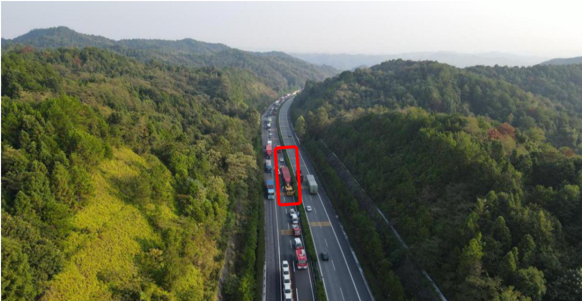
图1 事故现场方位照片
